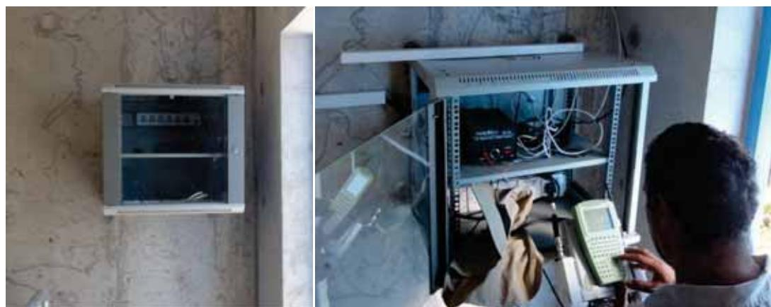
**Εικόνα 12 Κατάλληλο κιβώτιο για μόνιμη τοποθέτηση δέκτη GNSS**
