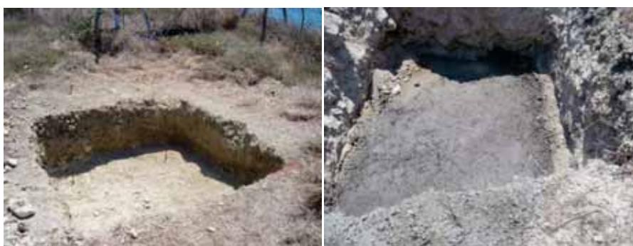
**Εικόνα 7 Αριστερά –Εκσκαφή πλάτους 1.5 x 1.5 m για βάθρο που βρίσκεται σε σταθερό έδαφος.. Δεξιά - Το σκυρόδεμα εξωμάλυνσης ρείθρου**
